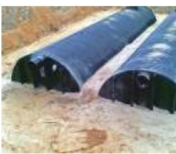
4. UKŁADANIE I ZAGĘSZCZANIE KOLEJNYCH WARSTW ZASYPKI ZBIORNIK
