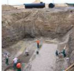
1. PRZYGOTOWANIE PODBUDOWY (FUNDAMENTU KRUSZYWOWEGO)
