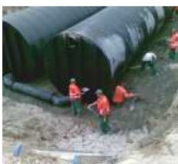
3. ZAGĘSZCZANIE STREFY PACHWINOWEJ ZBIORNIKA
